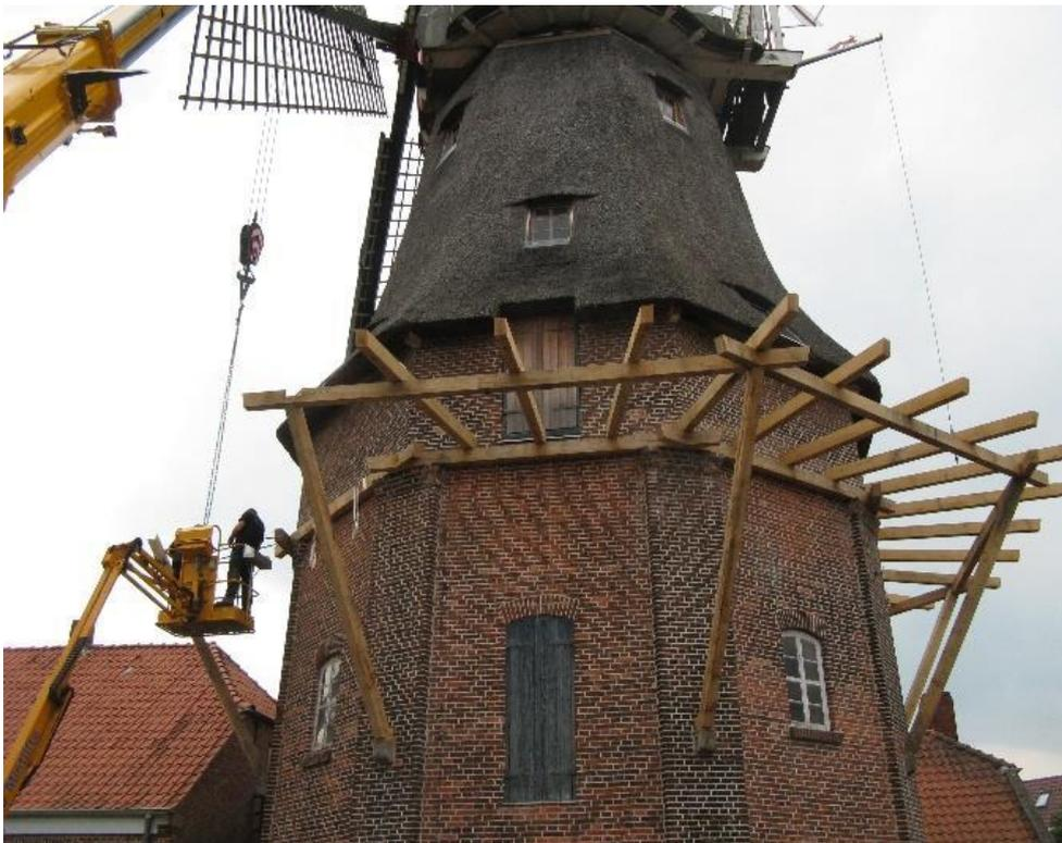
Am Mühlenkörper aufsitzende Füße der Schoren wurden mit extrem wasserbeständigen Robinienbrettern und Tropfleisten abgesichert.
